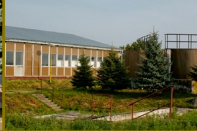
Čistička odpadových vôd
